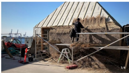
Tækkemestrene er i fuld gang med at lægge stråene på huset ved Bassin 7. Foto: Kasper Kudsk Baymler
