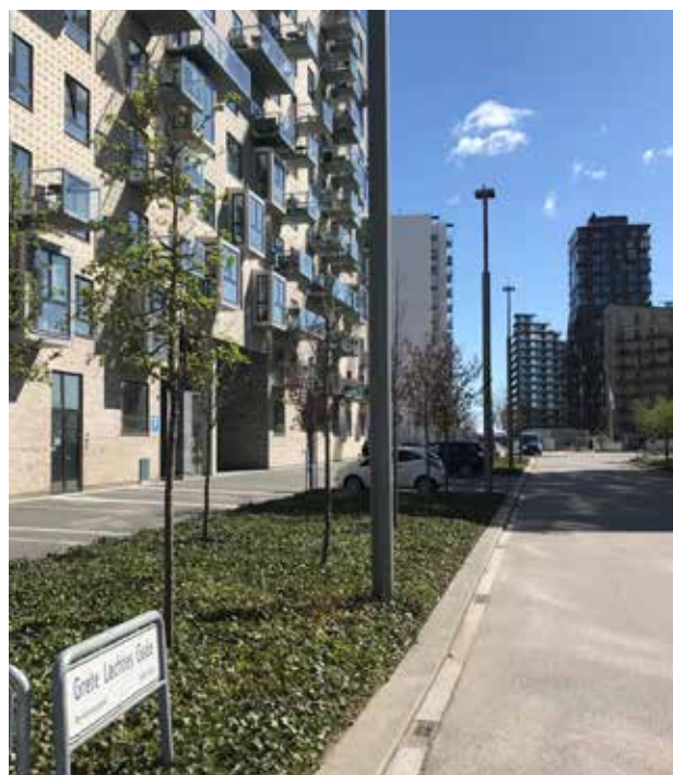
Opstammede træer i bunddække, Grete Løchtes Gade
