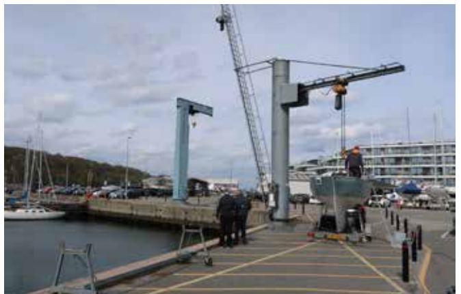
Manglende stiforbindelse langs mastekranen
