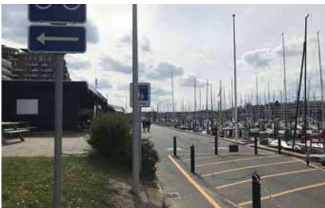
Manglende stiforbindelse langs mastekranen
