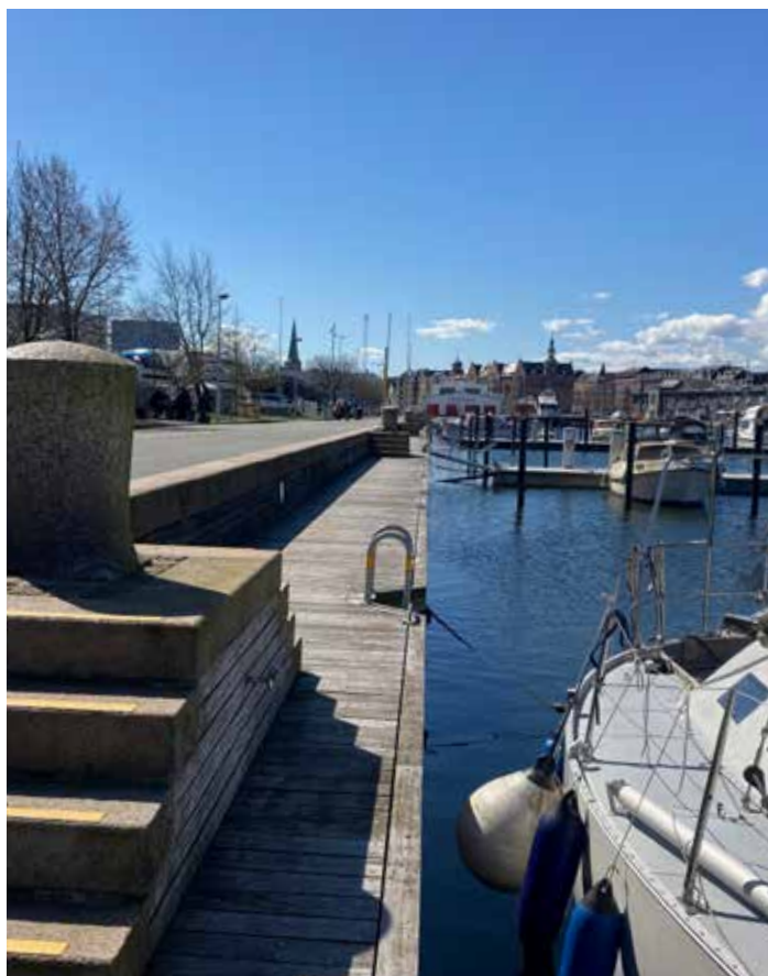
Granit bolværket langs Kystpromenaden på Aarhus Lystbådehavn, Øst
